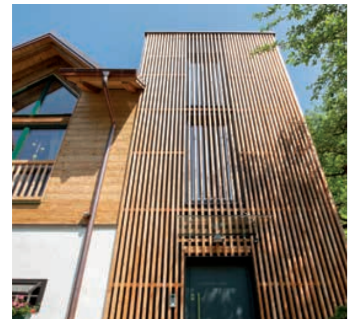
Zubau/Umbau Heustadel in ein Wohnhaus in Zusammenarbeit mit der Zimmerei Josef Konrad aus 8130 Frohnleiten; Fassadenelemente aus heimischer Lärche, verdeckt geschraubt.
